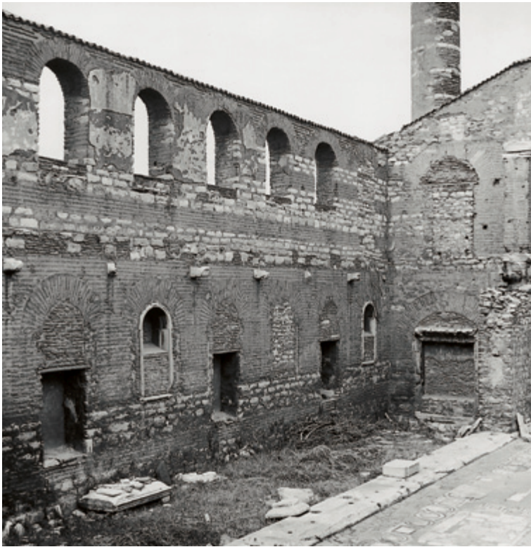
Abb. 4 Konstantinopel, Johanneskirche des Stoudios, südliches Seiten- schiff nach SW. Um 1500 wurde der Bau in eine Moschee umgewandelt und 1782 durch einen Brand u. a. seiner süd- lichen Säulenstellung beraubt. An der Längswand sind die Konsolen des Emporenbodens, an der Schmalwand die ehe- maligen Zugänge vom Narthex und der W-Empore zu erken- nen. Die Vielzahl der Fenster- unten mit Marmorlaibungen – gaben dem Innenraum eine gro- ße Lichtfülle. Bild: Urs Peschlow.
