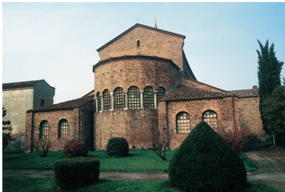
Abb. 11 Ravenna, S. Giovanni Evange- lista, Ansicht von Osten. Der Bau erlitt im Zweiten Welt- krieg starke Bombenschäden. Die wiederhergestellte Apsis zeigt eine durchgreifende Ver- änderung: In der oberen Partie wechselt das Polygon, es besitzt eine durchlaufende Fenster- zone. Dabei kann das Gewölbe ursprünglich nur aus leichten Tonröhren gebaut gewesen sein. Bild: Urs Peschlow.
